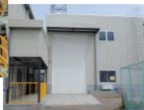
廃液処理棟外観
