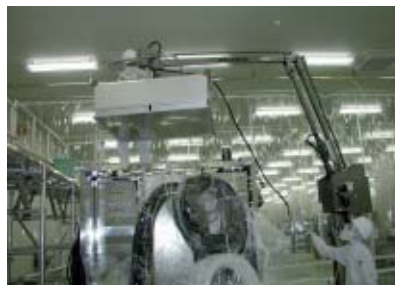
高所作業台およびバランス
