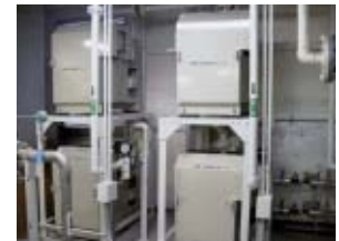
導入した空冷式真空ポンプ
