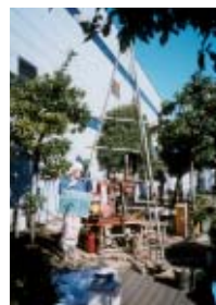
土壌調査 現場写真
