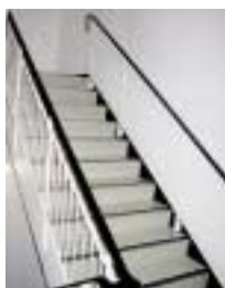
階段の手すり設置例
