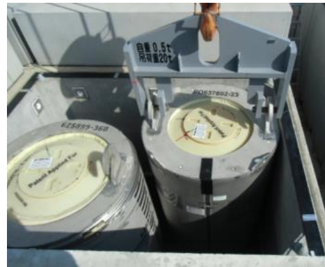
コンクリート製ボックス
