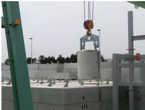
HIC の一時保管施設
