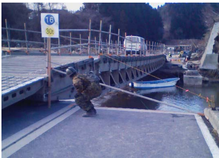
▲自衛隊による組立式橋梁設置後(3月19日7時40分片側交互通行開放)
