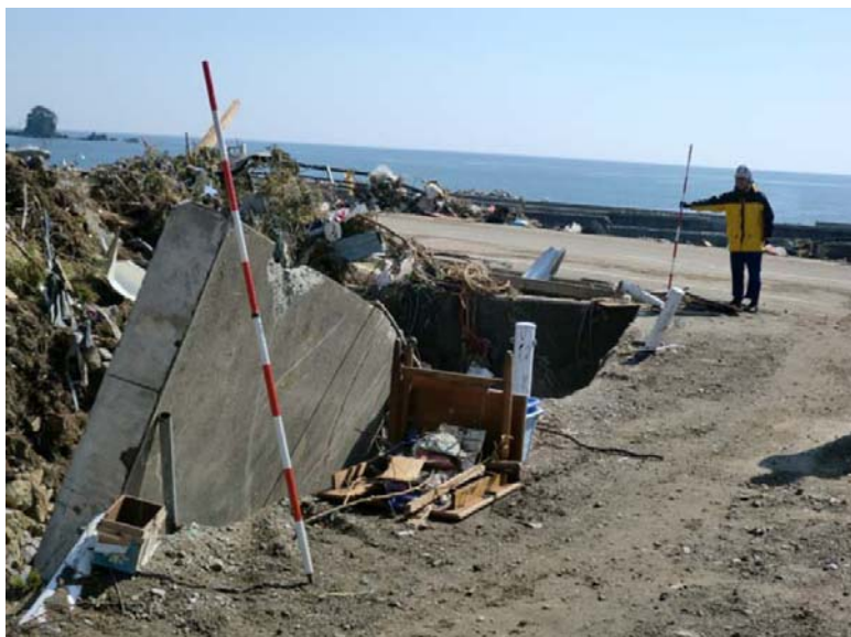
▲道路の被災状況調査 (陥没箇所)
