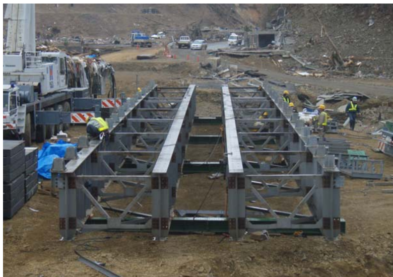
▲ 組立式橋梁の組立状況
