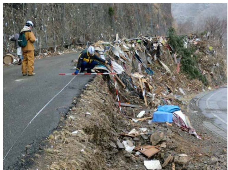
▲道路の被災状況調査 (ガードレール・路肩)
