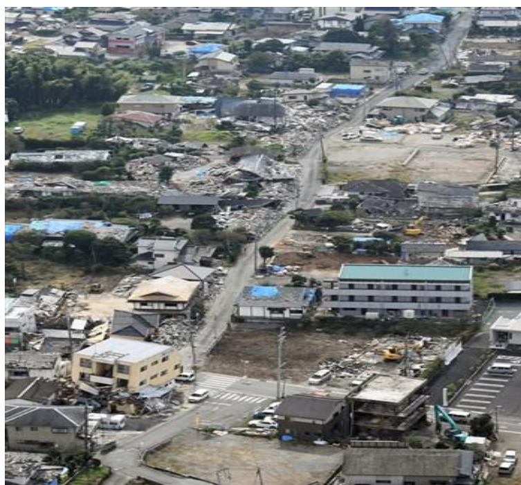
図表：多くの建物が倒壊した町中心部（宮園地区）
