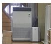
エアコン(室内機)
