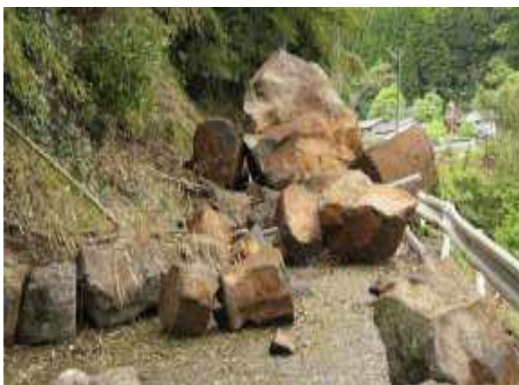
図表：崩落した巨石（内寺地区）
