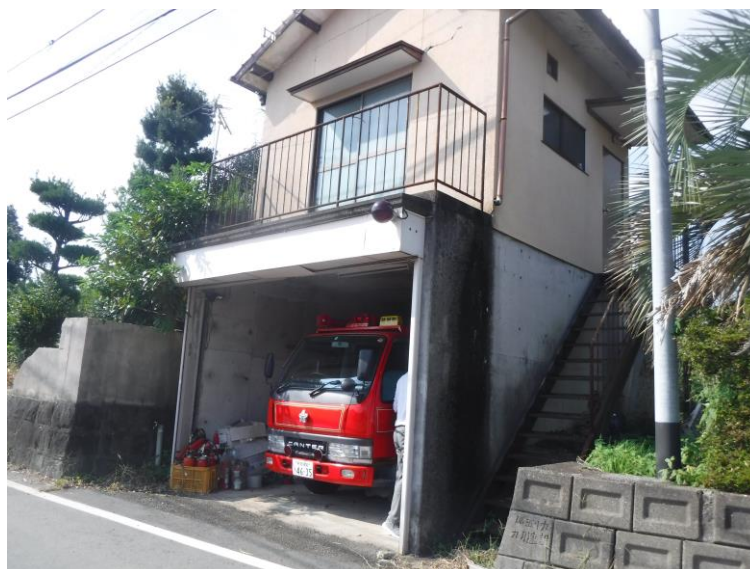
図表：被災した消防詰所（櫛島地区）
