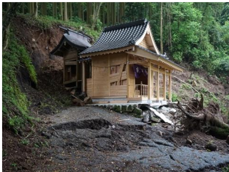
図表：被災した潮井神社（杉堂地区）
