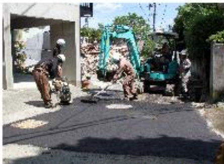
マンホールが突き出た生活道路の仮復旧工事
