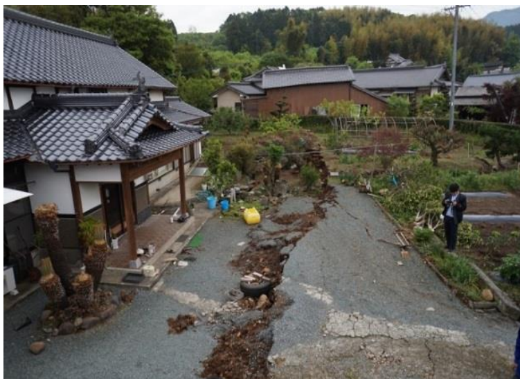
図表：個人宅敷地内に入ったV字型断層（谷川地区）
