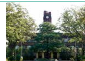
先端科学技術研究センター外観
