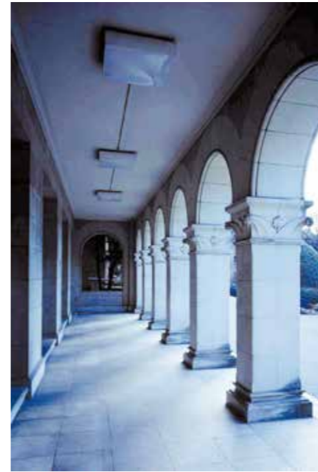
2号館エントランス
