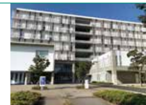
大気海洋研究棟
