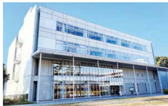
駒場図書館外観
