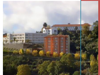
Rede de Residências dos SASUBI
