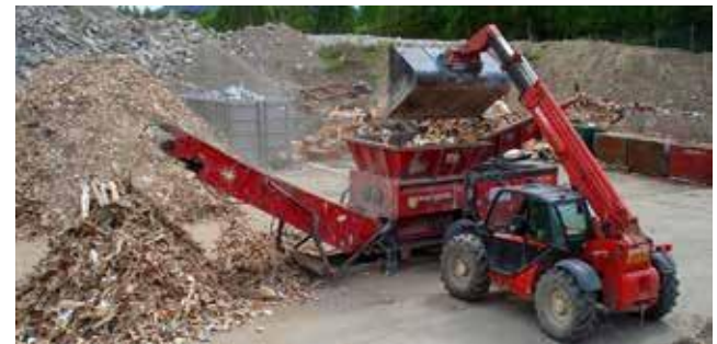
Rys.3. Oddzielanie drewna od gruzu budowlanego
