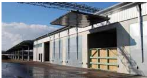
Fot. 2) Instalacja suchej fermentacji (pseudodyskontynuacyjnej) typu garażowego w Saalfeld w Niemczech (źródło: Bekon.eu)
