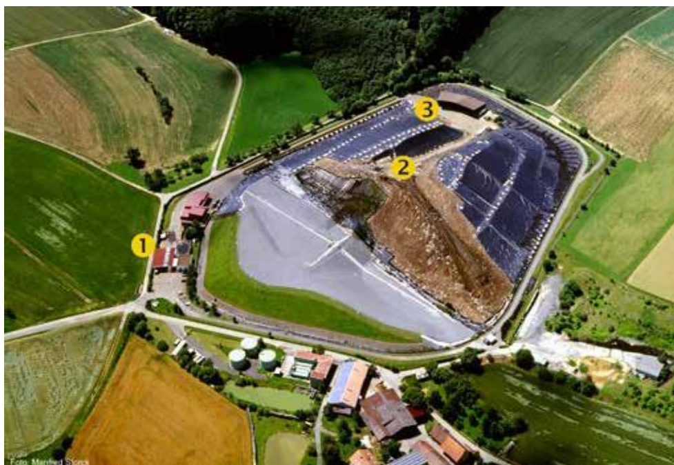
Fot. 2): Składowisko powierzchniowego odpadów niebezpiecznych w Billigheim.
