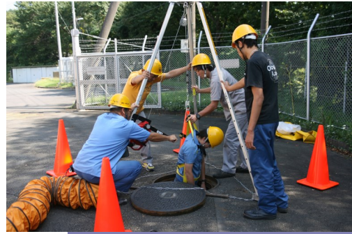
通信ケーブル配線工職
